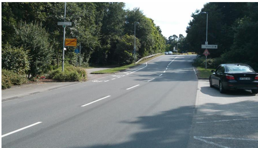
Abbildung 51: Fehlende Querungshilfe zum einseitigen gemeinsamen Geh-/Radweg am südlichen Ende der Kurt-Schumacher-Straße
