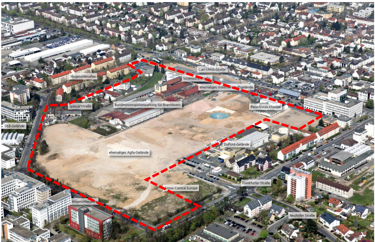
Abbildung 1: Luftbild und Nutzungen (Rahmenplan "Stadtquartier Süd" BS+, 2014, angepasst) mit Abgrenzung des Geltungsbereichs des Bebauungsplans Nr. 55 (rot gestrichelt), Schrägansicht von Südosten nach Nordwesten
